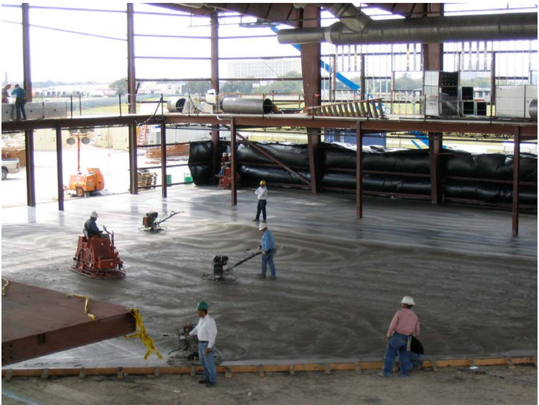
Main hangar concrete pour
