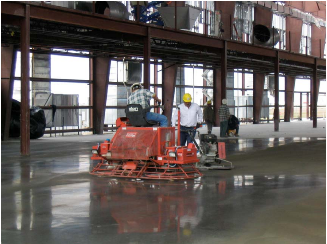
Concrete pour finishing
