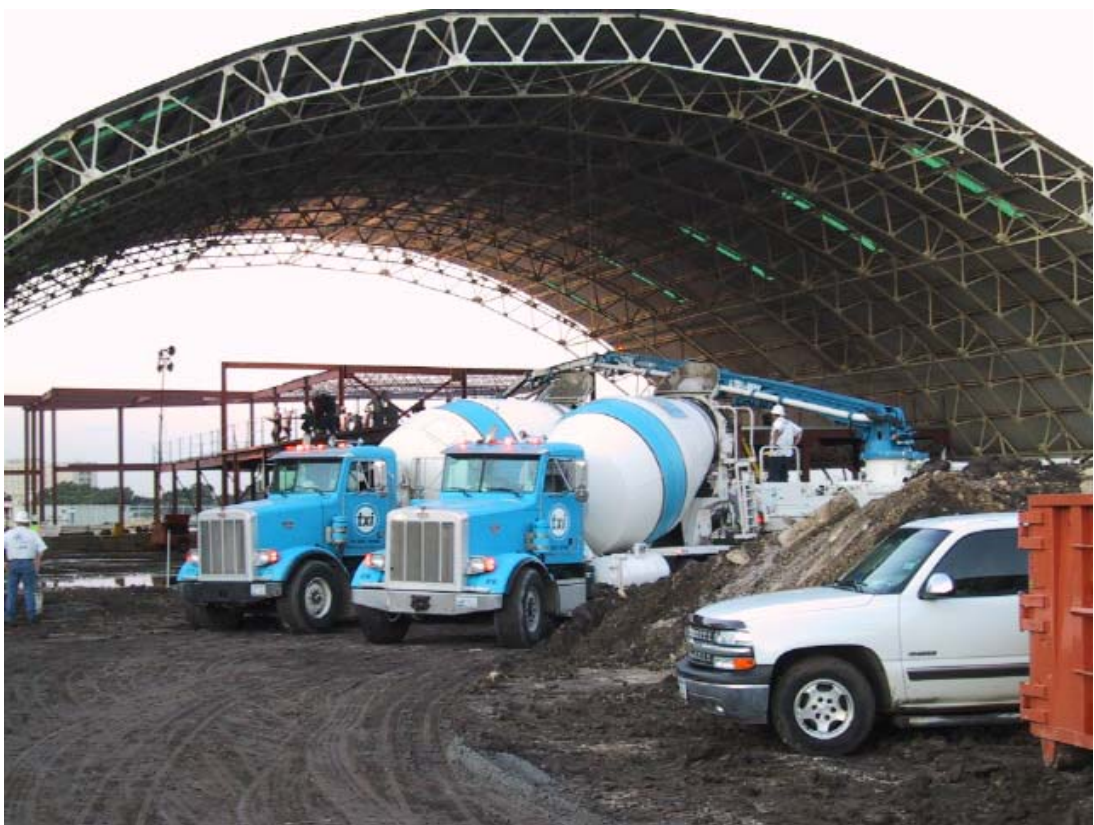
Pumping concrete for 2 nd floor pour
