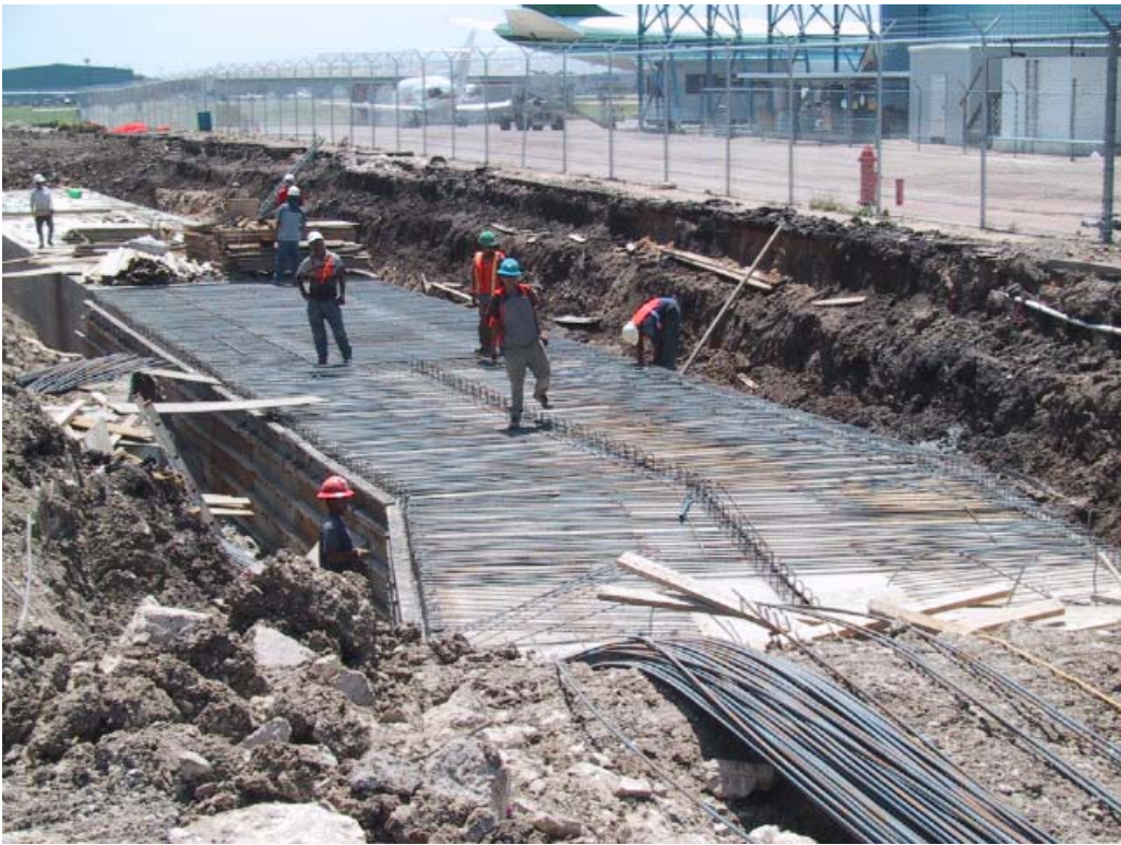
Last section of culvert ready for top pour
